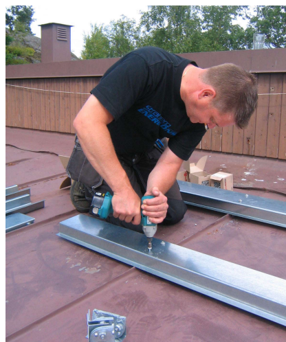
Figur 3: Monteringsskenor skruvas fast i vinkelbleck på falsfäste.
