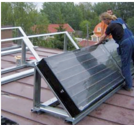
Bild 4 och 5: Lyft solfångaren på plats med hjälp av lyftkran. Med stor precision kan de flesta kranförare sätta solfångaren rätt på millimetern.
