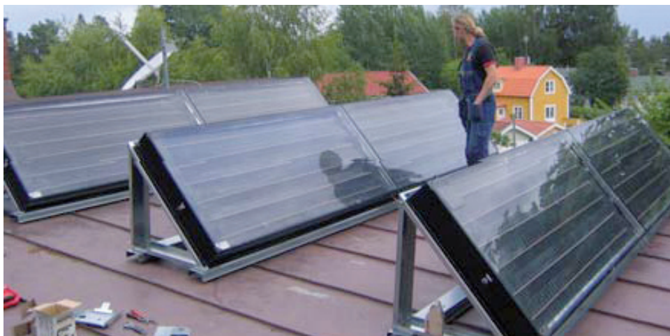
Bild 7: Tre solfångare Aquasol Long färdigmonterade på ett falsat plåttak i Huddinge.
