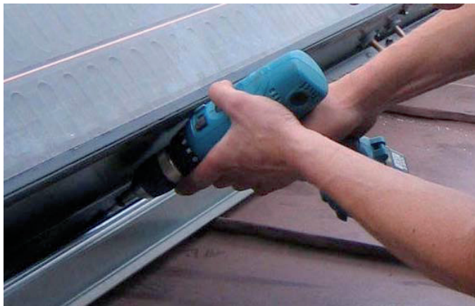
Bild 6: Solfångaren skruvas fast i övre och undre monteringskenan med ett avstånd av 40 mm.
