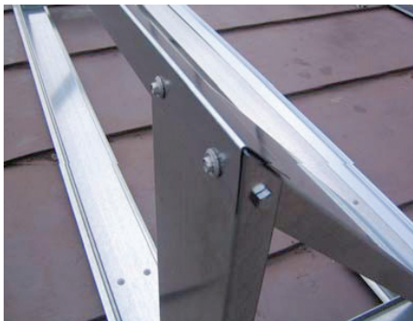
Bild 3: Den övre monteringskenan (V-formad) skruvas fast på baksidan av bentriangeln. Detta för att undvika att "hattarna" på skruven kommer i vägen då solfångaren ska läggas på plats.
