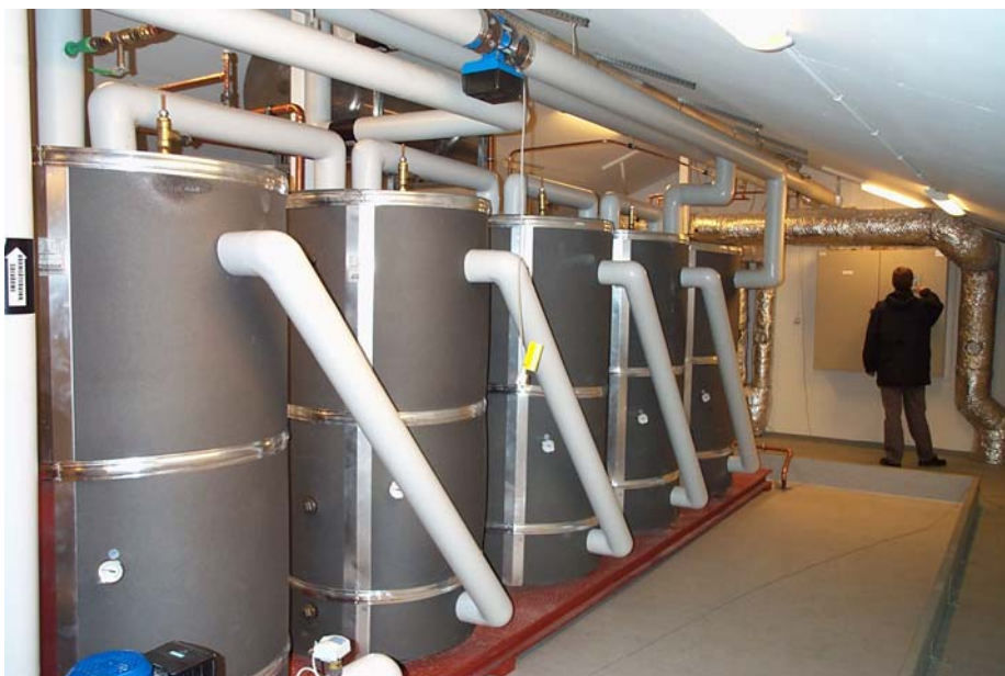
Figur 6.2 Ackumulatorn består av 5 cylindriska tankar, placerade i ett rymligt apparatrum i vindsplanet under solfångarna.
